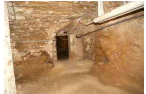
Gang unter der Straße hindurch
